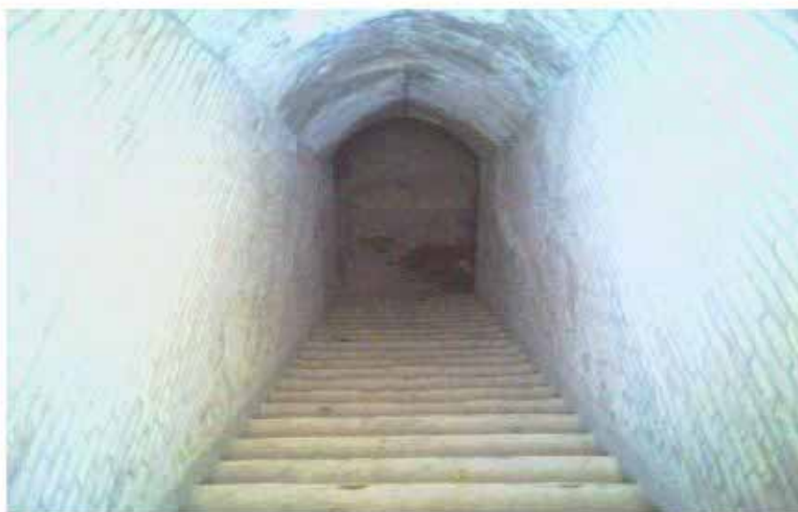
ورودی آب انبار
